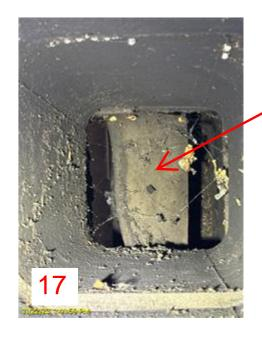
BROKEN DAMPER INSIDE CHIMNEY FLUE
