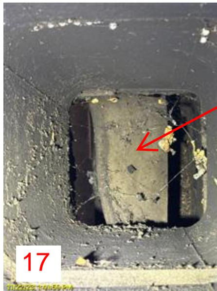
BROKEN DAMPER INSIDE CHIMNEY FLUE
